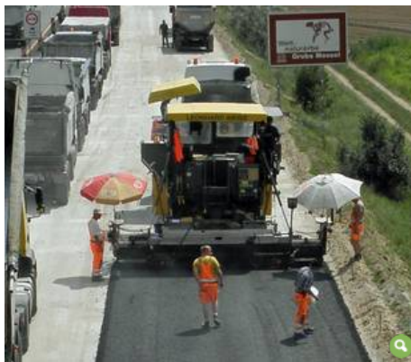
Abbildung 1: Etwa 80 % des Bitumens gehen in den Walzasphalteinbau (Foto: R. Rühl)
