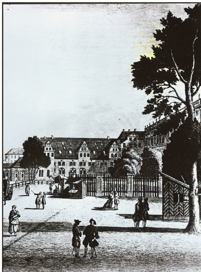
Abb. 2: Der Apothekenflügel war als freistehender Seitenflügel der Nordfassade des Berliner Schlosses in Richtung Lustgarten vorgelagert. Dieses typische Renaissancegebäude wurde Ende des 16. Jahrhunderts errichtet und 1950 abgerissen. Die Hofapotheke befand sich im Erdgeschoss des Apothekenflügels (Quelle: Staatsbibliothek Berlin).
