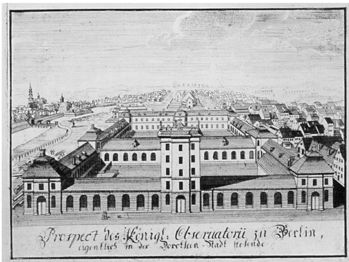
Abb. 1: Neuer Marstall in der Dorotheenstadt; Ansicht von Norden mit dem in der Letzten Straße (heute Dorotheenstraße) gelegenen Gebäudeteilen: Vorn in der Mitte der Turm des Observatoriums der Societät der Wissenschaften. Im Pavillon an der rechten Gebäudeecke (heute Ecke Dorotheenstr./Charlottenstr.) war das Anatomische Theater, der Kern des Collegium Medico-chirurgicum, untergebracht. Auf dem Gelände des Neuen Marstalls befindet sich heute das 1909 gebaute Gebäude der Staatsbibliothek Unter den Linden (Quelle: Archiv des Autors).
