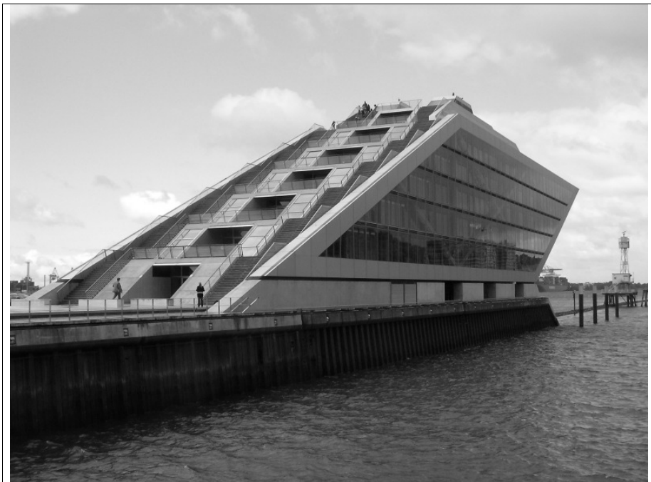
Begehbares Gebäude am Hafen
