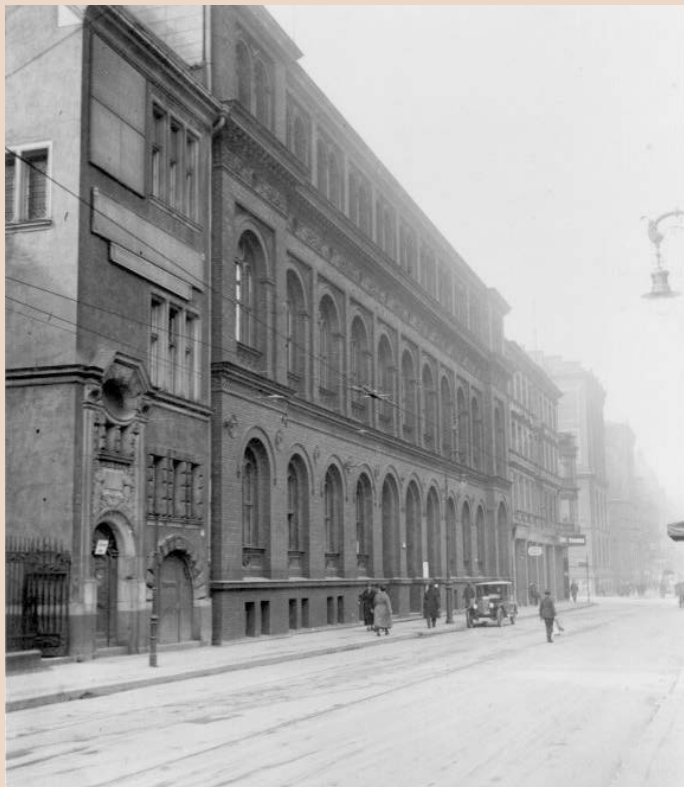
Für die Nutzung durch das Museum für Meereskunde wurde das ehemalige chemische Institut um ein Geschoss aufgestockt, Stiftung Deutsches Technikmuseum Berlin, Foto: Historisches Archiv, Museum für Meereskunde
