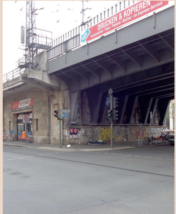
Blick auf die Ecke Georgenstraße/Geschwister-Scholl-Straße zum ehemaligen Standort des Gropius'schen Dioramas, Foto: Alexander Kraft 2017
