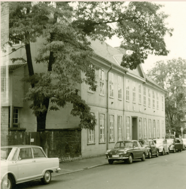
Abb. 14: Das Chemische Laboratorium mit verputzter Fassade, um 1965.
