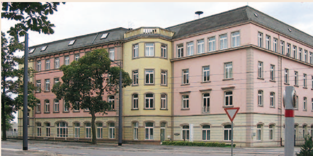
Das ehemalige Fabrikations- und Verwaltungsgebäude der Chemischen Fabrik von Heyden in Radebeul (heute Sitz der Arevipharma GmbH).
