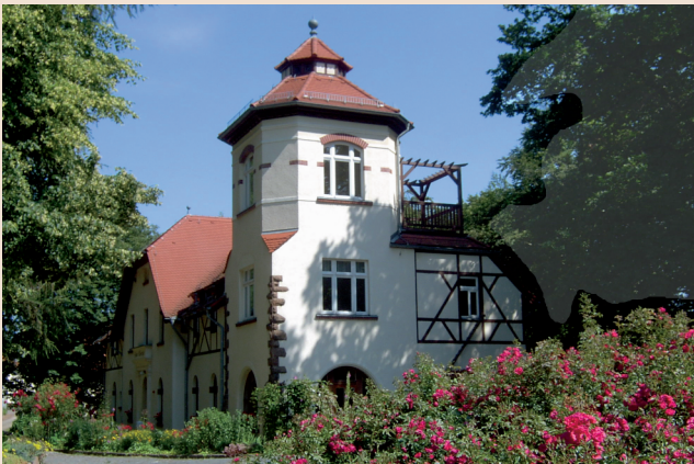
Das Haus „Energie“ vom Nordwesten, nach der Sanierung 1994
