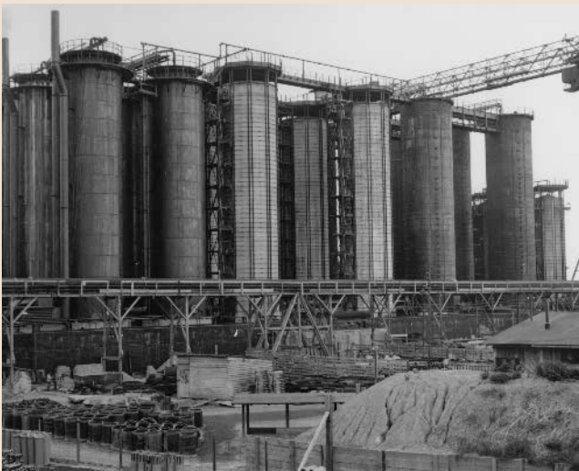
Teilansicht einer Salpetersäureanlage nach dem Ostwald-Brauer-Verfahren, um 1917 (Werksarchiv der BASF)
